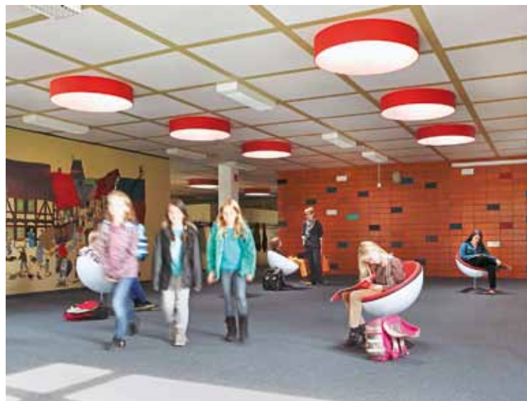
Über der alten Unterdecke mit ihren Lichtröhren sind neue Flachdachfenster montiert und erzeugen eine helle und freundliche Atmosphäre
