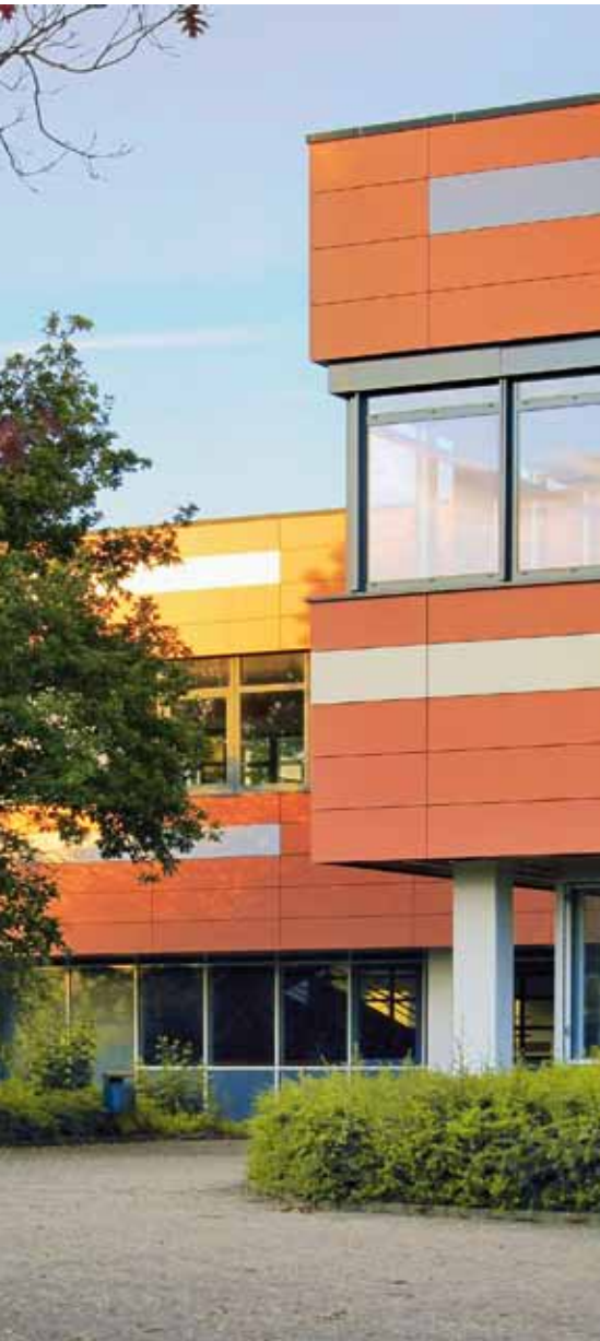
Die Fassade wurde mit HPL-Platten farbig bekleidet
