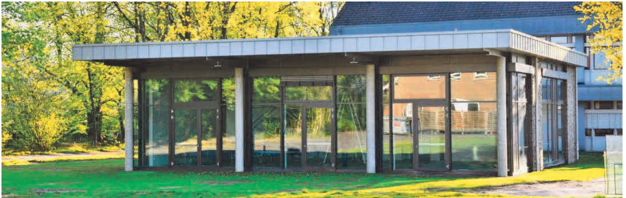
Das Bürgerhaus mit einer Gesamtfläche von 330 Quadratmetern ist fertig: Der Multifunktionsaal bietet mit seinen 161 Quadratmetern Platz für Veranstaltungen mit rund 150 Personen. Im 99 Quadratmeter großen Foyer sind Ausstellungen aller Art möglich. Fotos: Schmidt
